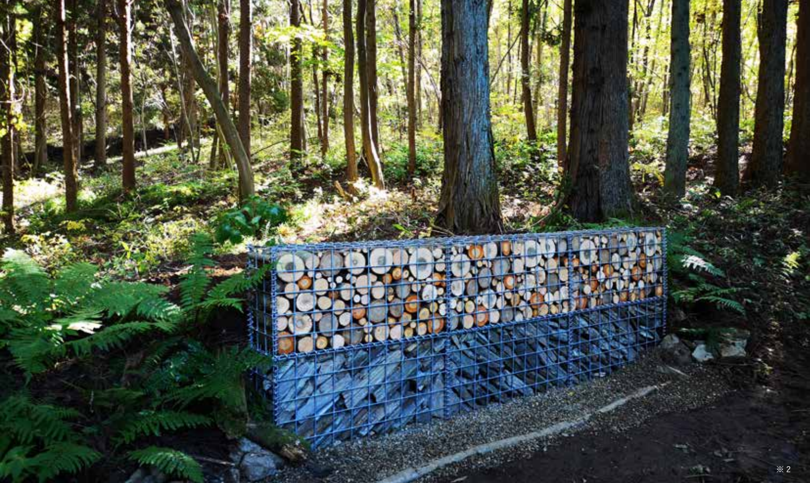
完成したフトンカゴ /Completed gabion box
