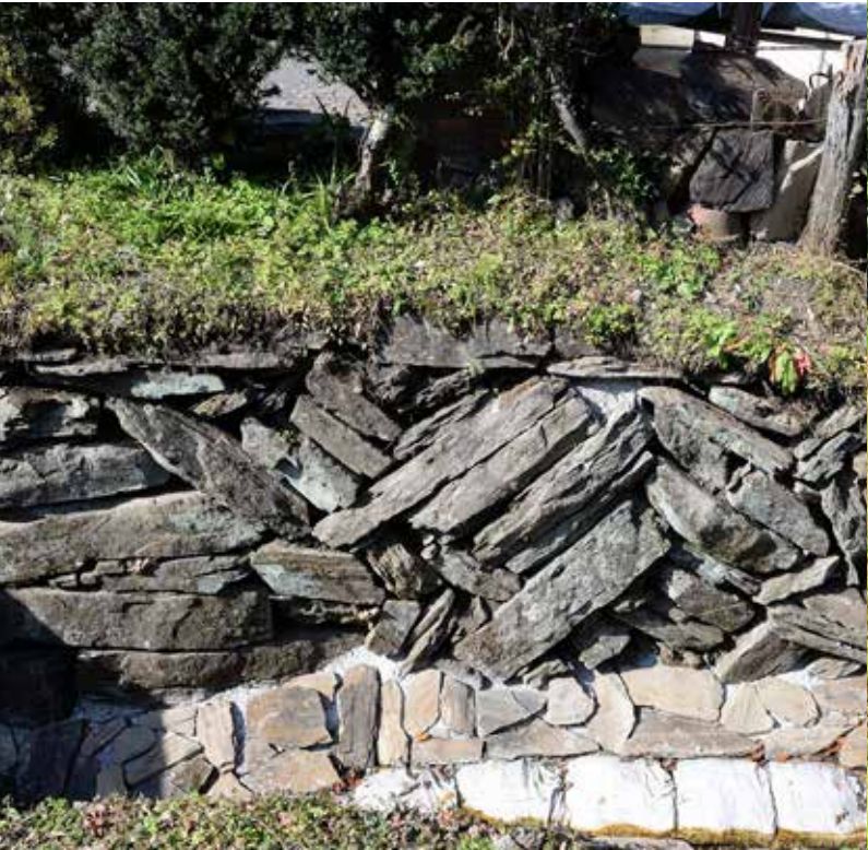
変成岩を利用した「矢羽根積み」を観察する蟹澤名誉教授と長瀬准教授（中田字上矢造） Professor Kanizawa and Associate Professor Nagase (Nakada miyazukuri) observes "yabanezumi" using metamorphic rock
